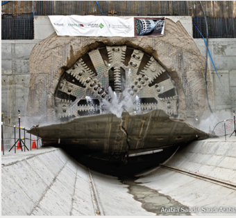
Finalización del primer tramo de la línea 5 del Metro de Riad. Tomás Arranz. Finishing the first tunnel section of line 5 of the Riyadh Metro.
