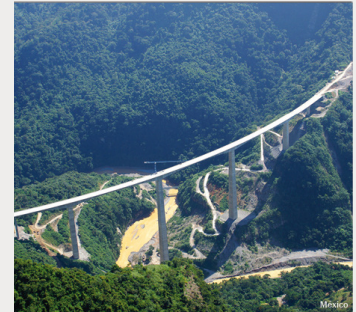
Viaducto Borja Gil Navarrete. Autopista de Nuevo Necaxa-Tehuacán. Enrique Díaz.
