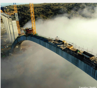
Acabando las pilas del viaducto récord mundial en arco ferroviario. Viaducto de Almonte. AVE Alcántara-Garrovillas. David Carnero. Finishing the piers over the world record arch of a railway bridge. Almonte Viaduct. Alcántara-Garrovillas HSR.
