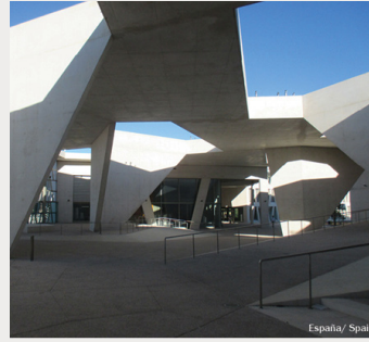
Construcción del nuevo colegio alemán en Madrid. Sergio Santos. New Deutsche Schule construction in Madrid.
