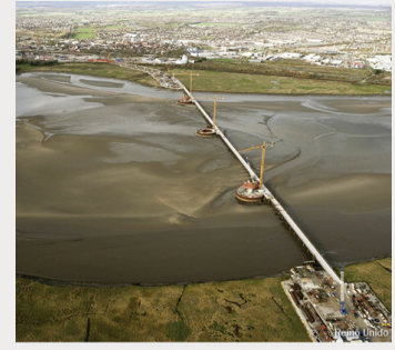
Construcción de los cofferdam del puente de Mersey. Fernando Florez. Cofferdam construction in the Mersey Bridge UK
